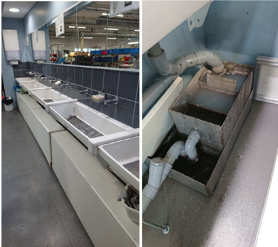
Figure 21 : Bacs de rinçage final des outils d’application et décanteur de type dentaire des eaux de rinçage
